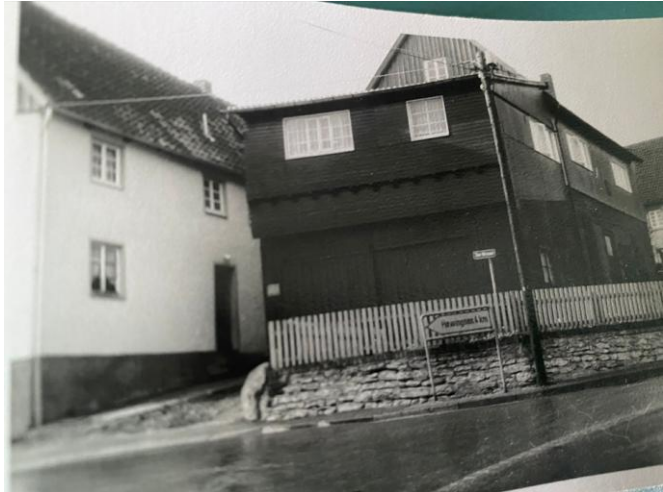
Wohnhaus Bause und Bausen Bude
