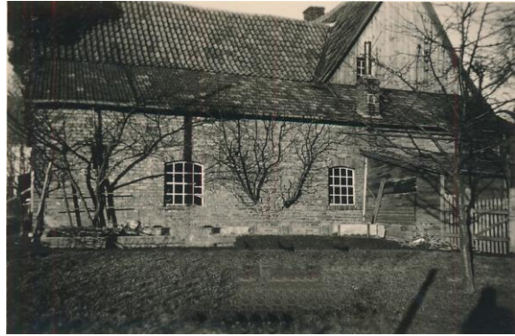
Haus Nettelhoff von Gunethe aus gesehen
